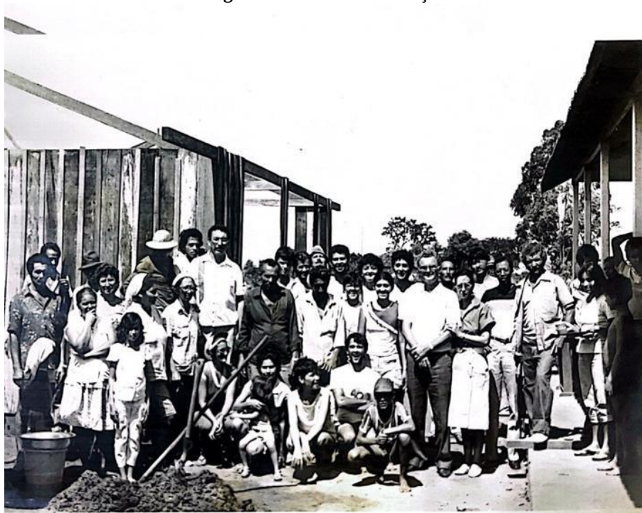
Figura 3: Durante a construção.
