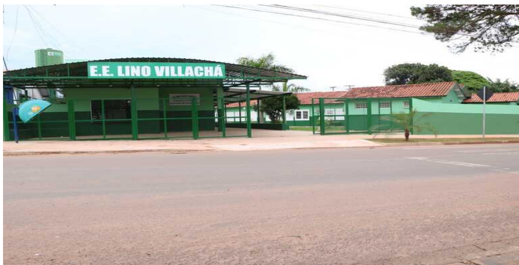
Figura 10: Frente da Escola Estadual Lino Villachá após a Reforma
