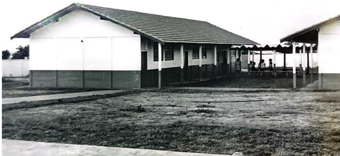
Figura 6: Primeira etapa da construção concluída.
