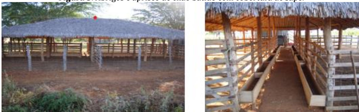
Figura 3. Abrigos e aprisco de chão batido com cobertura de sapê.
