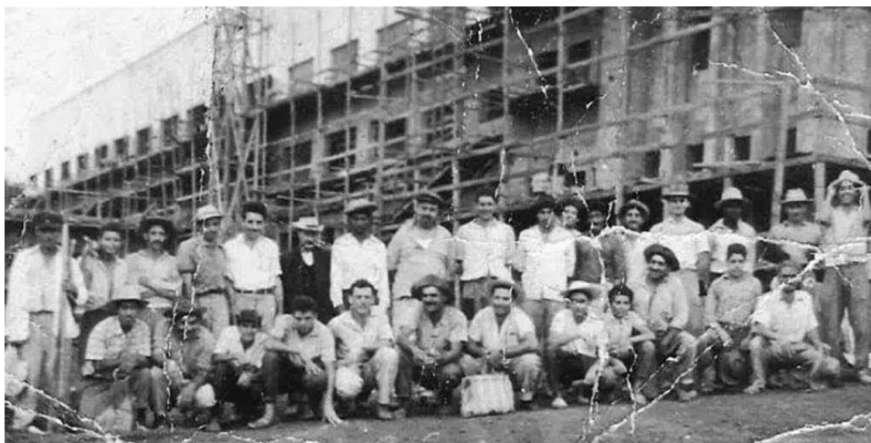
Figura5: Construtores do Seminário no início das obras na década de 60
