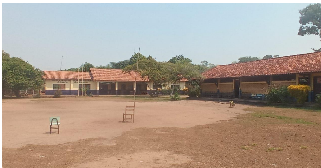
Figura 11: Escola Santo Antônio - Cururu/Lago Grande
