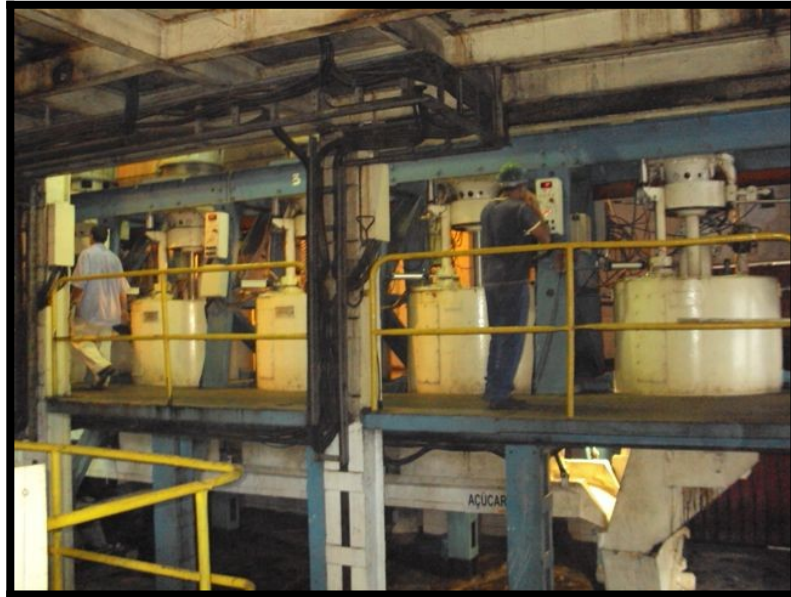
Figura 18: conjunto de Centrifugas de Açúcar
