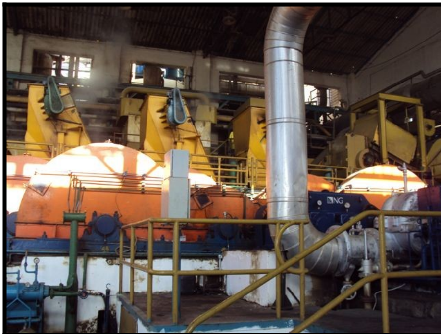
Figura 11: Visão geral do setor de Moenda
