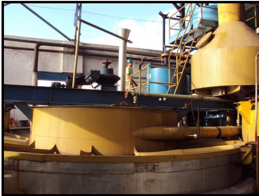
Figura 14: Visão geral do decantador
