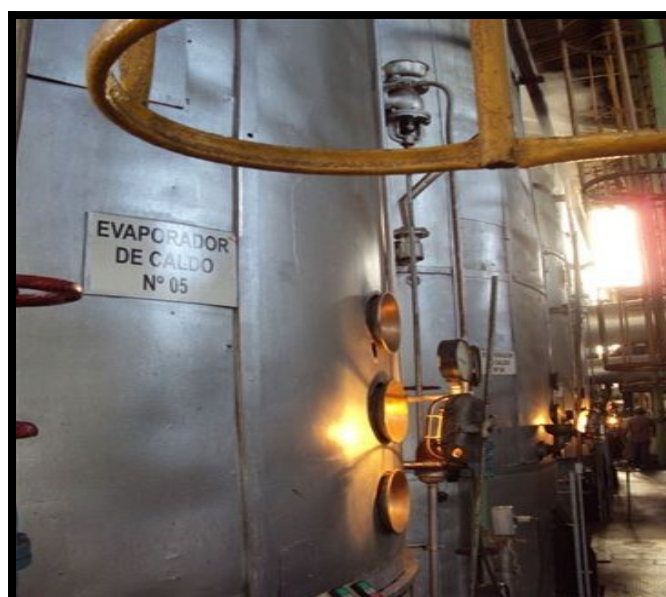
Figura 16: conjunto de evaporadores de múltiplos efeitos da Usina Monte Alegre
