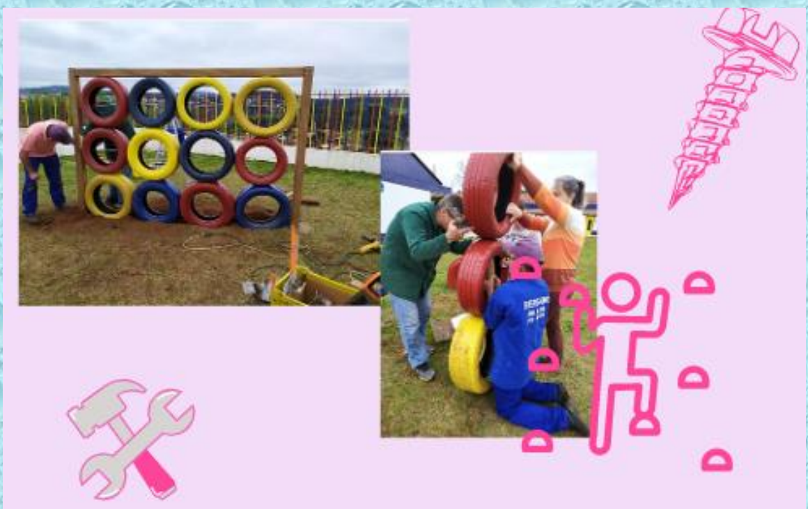
Figura 6: A construção da escada de pneus
