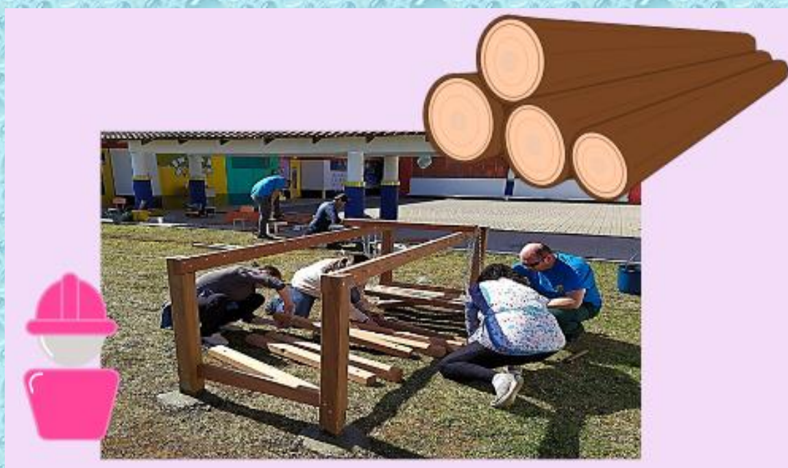
Figura 2: A construção da ponte de forma colaborativa
