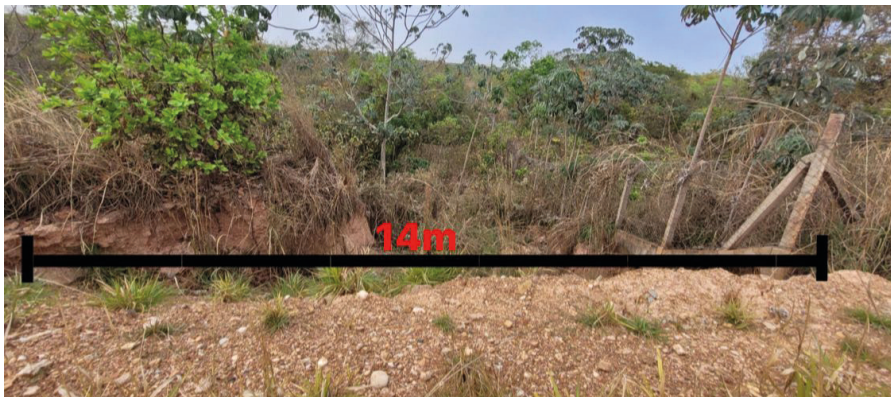
Figura 10 – Imagem da erosão do aterro e a indicação da largura.
