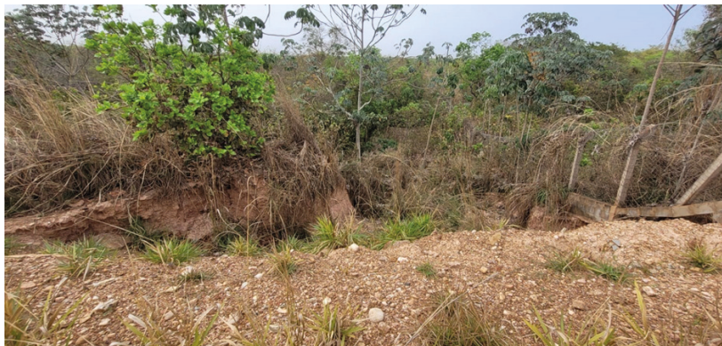
Figura 7 – Imagem da erosão no aterro.
