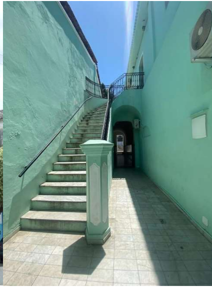
Foto 12: Escadaria de entrada
