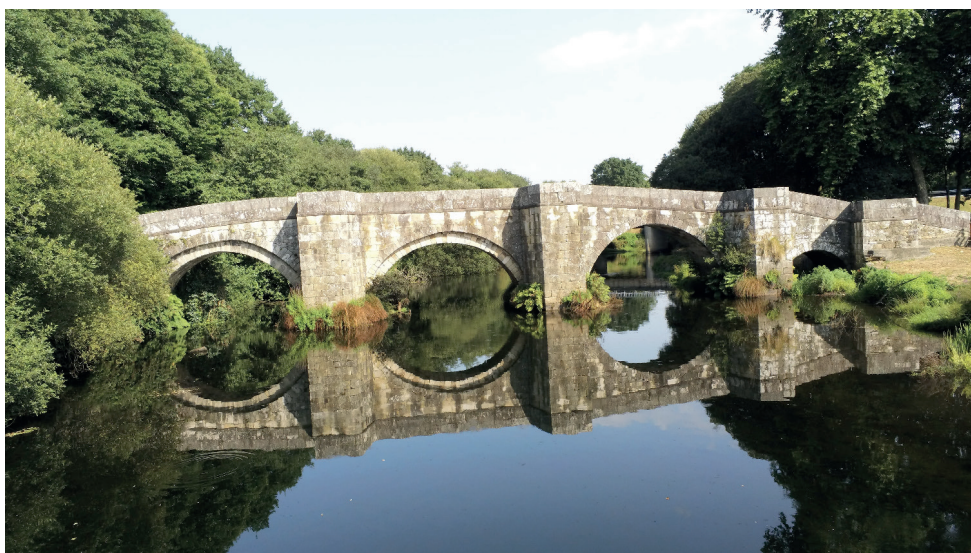
Figura 3: Vista general del alzado aguas abajo del Puente de Brandomil, en imagen captada con el drone multi rotor empleado en la inspección de este artículo (fotografía del autor).
