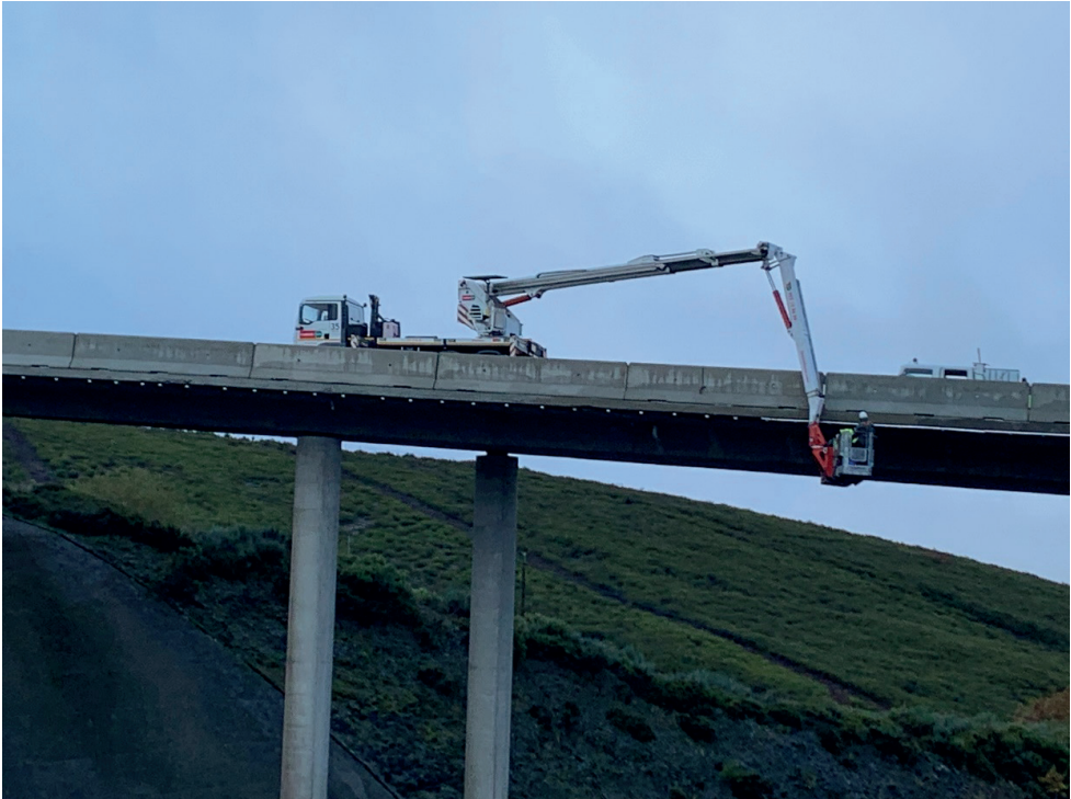
Figura 1: Inspección del tablero de un viaducto que salva la Autovía de las Rías Bajas (A – 52), a la altura del municipio de A Gudiña, en la provincia de Ourense (fotografía del autor).
