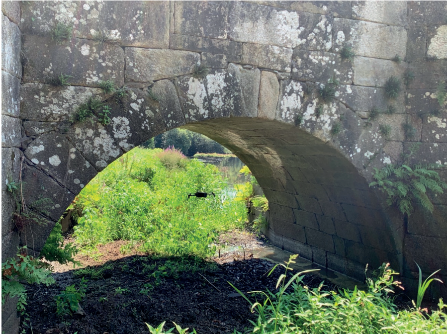
Figura 6: Drone multi rotor empleado en la inspección del Puente de Brandomil, adentrándose en el interior de la bóveda del arco menor para su inspección desde el lado aguas arriba del Puente (fotografía del autor).
