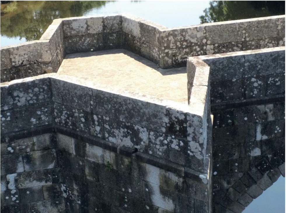
Figura 5: Vista general de la parte superior de uno de los tajamares del Puente de Brandomil, en imagen captada con el dron multi rotor empleado en la inspección (fotografía del autor).
