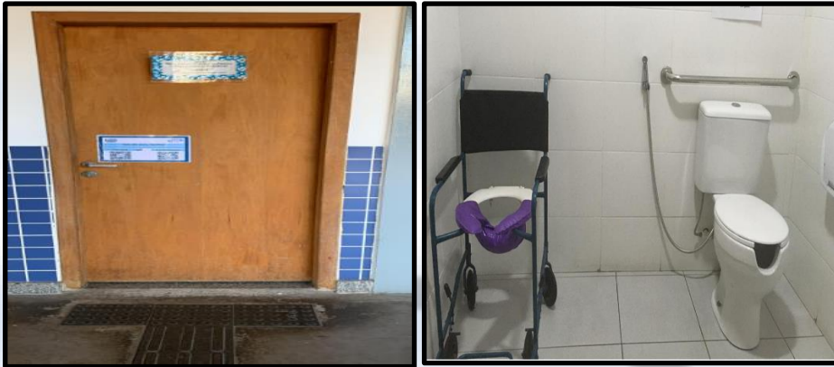
Figura 3: Fotografia de porta e banheiro acessíveis
