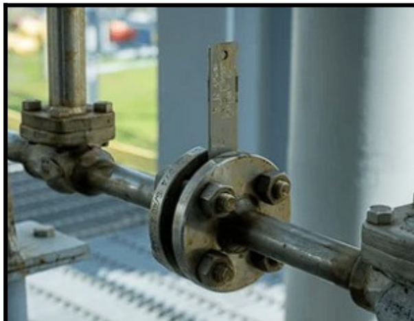
Figura 1 – Placa de Orifício.
