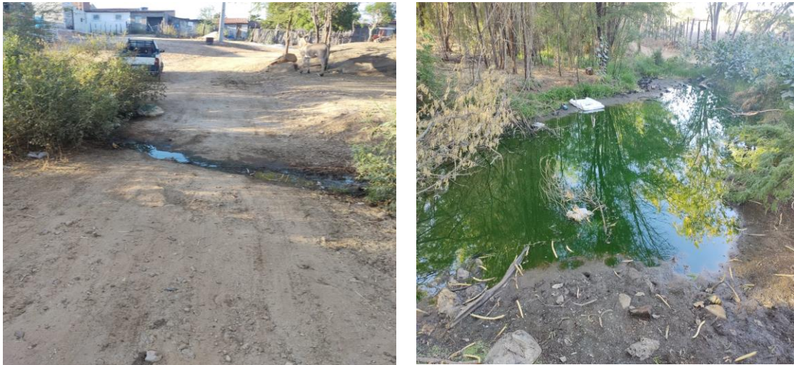
Figura 3 – Registros de esgotos lançados diretamente no solo em algumas localidades do município.
