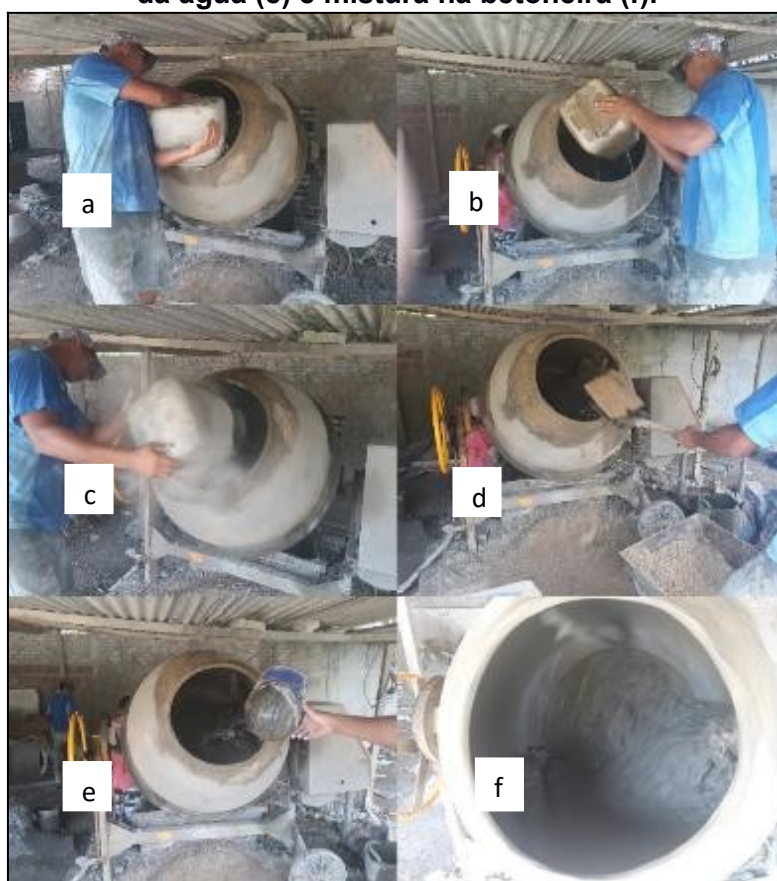
Figura 4.11 – Mistura do concreto: adição de brita (a), água (b), cimento (c), areia (d), ajuste da água (e) e mistura na betoneira (f).
