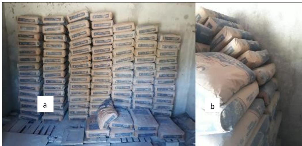
Figura 4.2 – Estocagem do cimento em pilhas (a) e detalhe dos cimentos em contato com a parede dos fundos (b).
