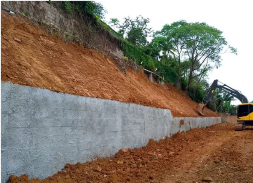
Figura 09. Muro de arrimo em concreto armado
