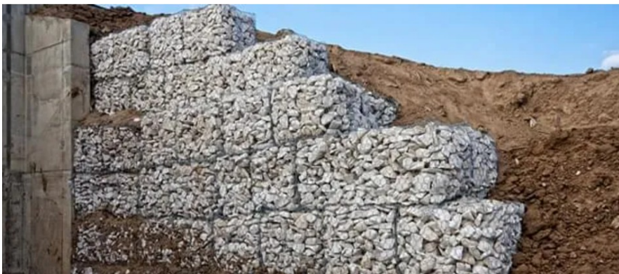
Figura 10. Muro de Arrimo de gabião
