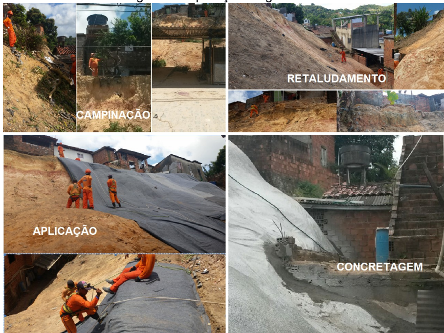
Figura 21. Aplicação da geomanta
