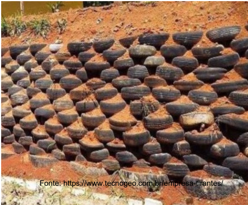
Figura 11. Contenção com pneus
