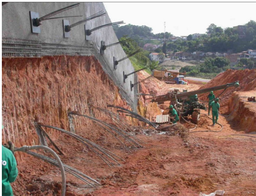
Figura 12. Tirantes em contenção por ancoragem
