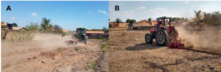
Figura 2: Preparo da área da horta (2A) e construção dos canteiros (2B).
