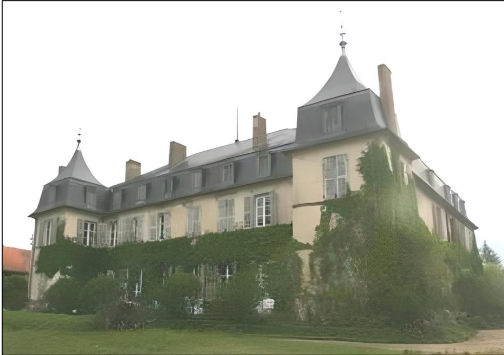
Figura 3 – Mansão de taipa construída há 300 anos, na França
