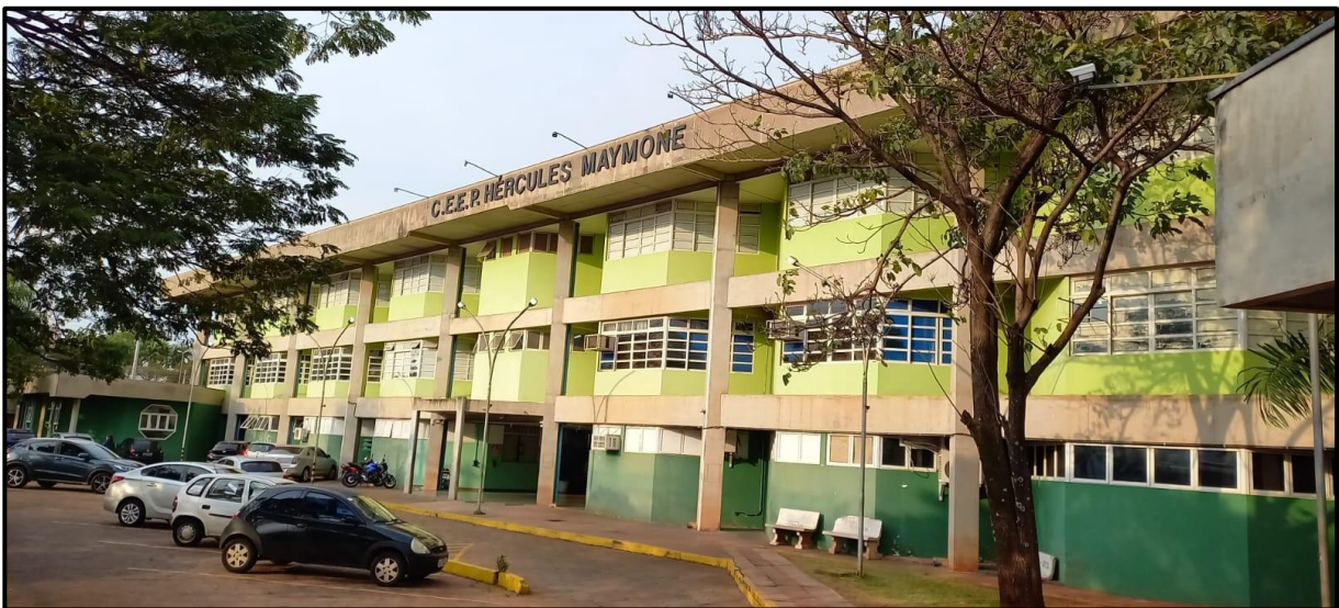
Figura 2 - Foto ampliada da fachada
