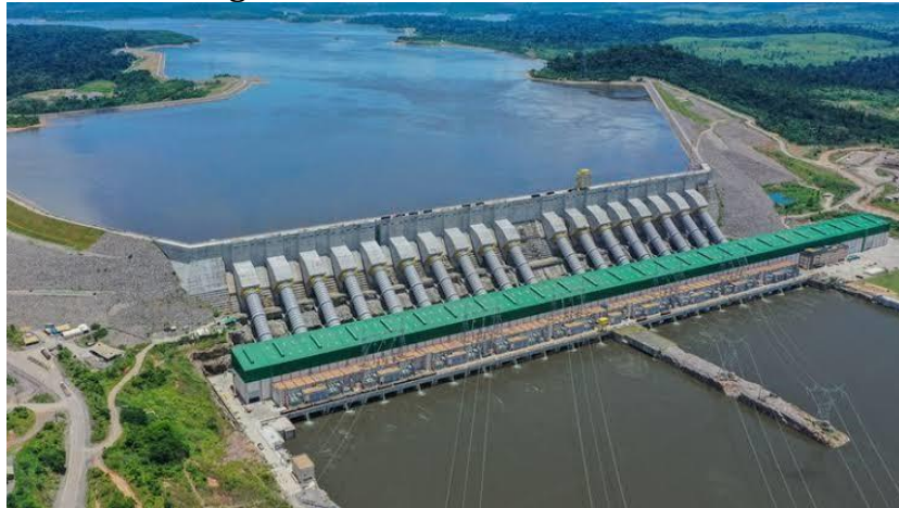
Figura 3 - Hidrelétrica de Belo Monte
