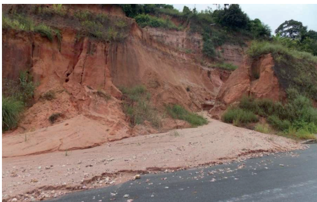
Figura 7: Pista parcialmente invadida por deslizamento de terra
