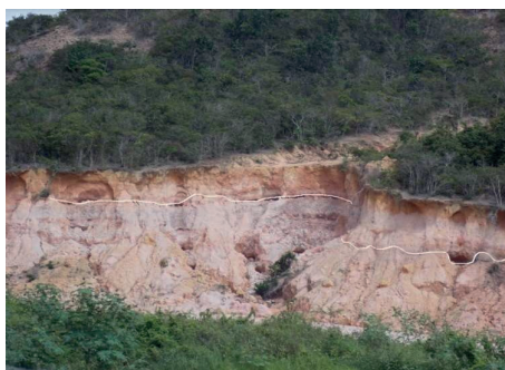
Figura 17: Deslizamento de terra localizado
