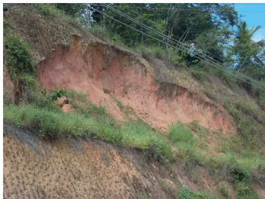
Figura 13: Desprendimento ou queda
