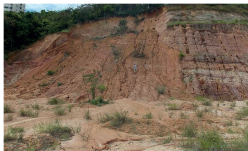
Figura 20: Sulcos provocados pela erosão
