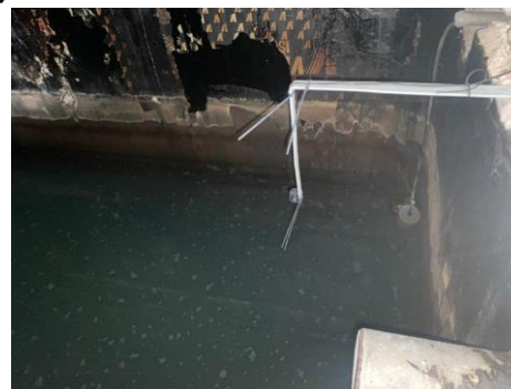
Figura 3: a) Sensor Ultrassônico JSN-SR04T 2.0 e Módulo para Arduino [9]. b) Instalação do sensor na Caixa Superior.
