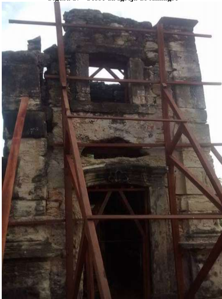
Figura 17– Torre da Igreja do Almagre
