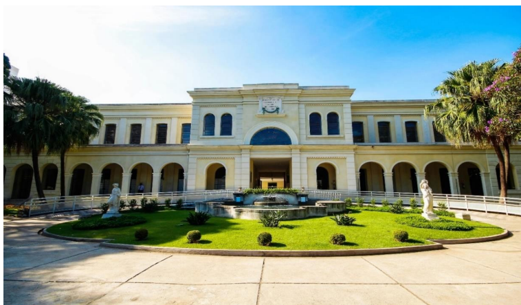
Fotografia 2 – Museu da Imigração – fachada atual
