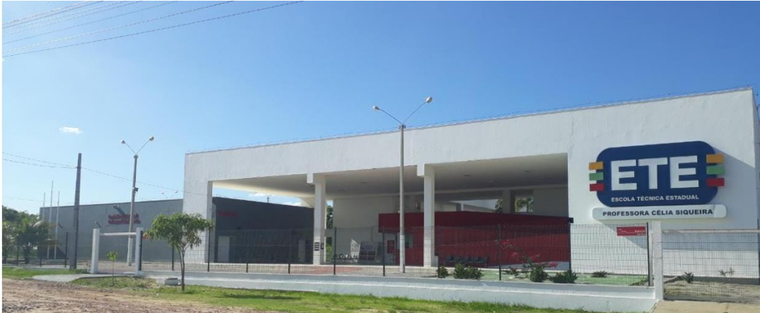
Foto 1 – Fachada direita da ETE Professora Célia Siqueira
