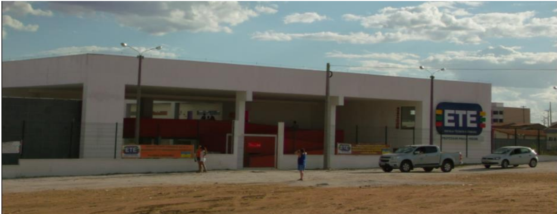
Foto 3 – Fachada esquerda da ETE Paulo Freire
