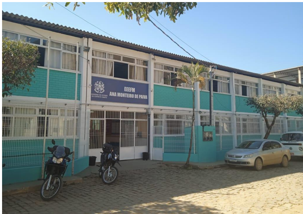
Figura 10 – Fachada da EEEFM “Ana Monteiro de Paiva”
