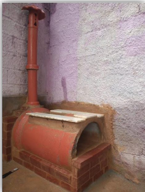
Figura 40 - construção do fogão/forno à lenha da Cozinha Socioambiental/Cantinho Eco-reflexivo. 19.nov.2020 - Figura 41 - Canteiro externo da goiabeira e vista parcial da Área de Recepção. 23.nov.2020
