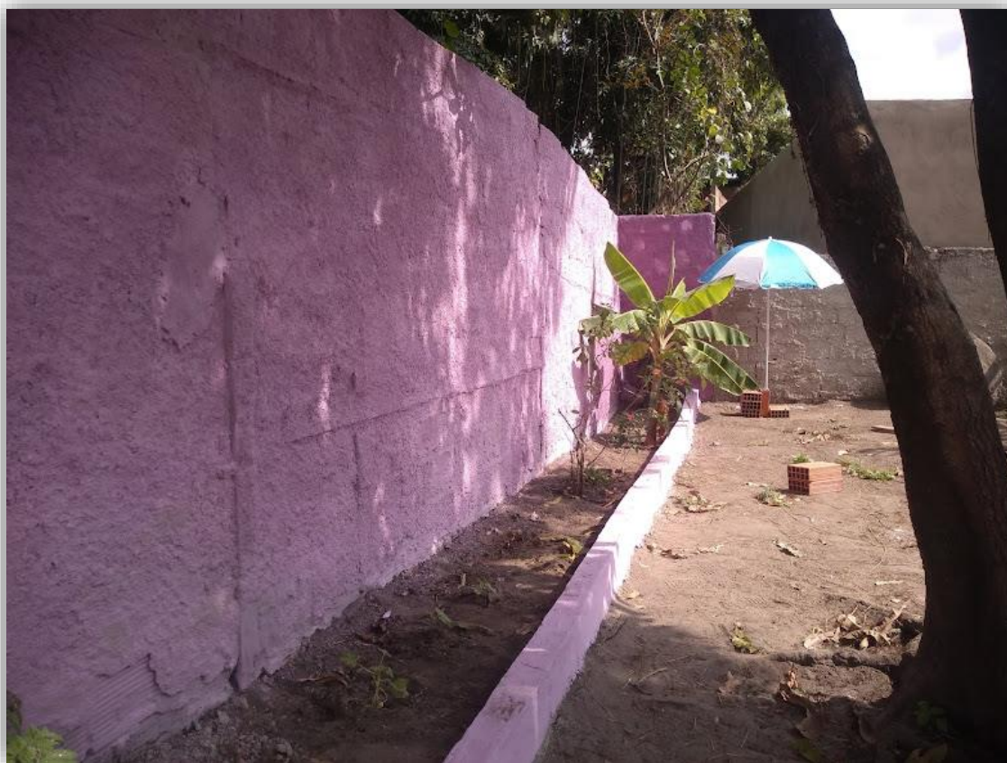
Figura 36 - primeira pintura dos muros e dos canteiros externos feitos com cal e corante violeta. 29.jul.2020
