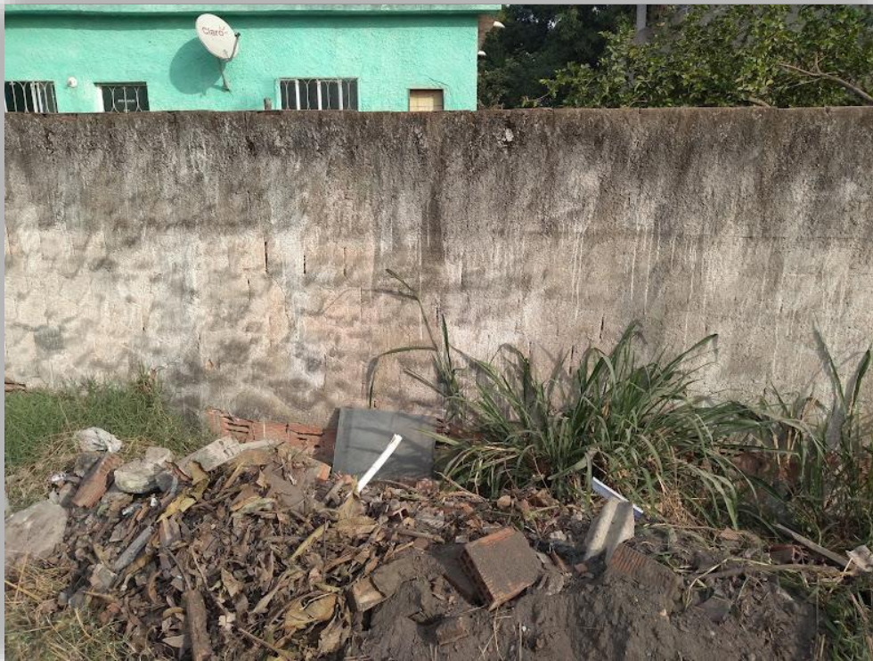
Figura 9 - restos de materiais de construção foram utilizados para aterrar e preparar o espaço da calçada da fachada externa. 03.jul.2019
