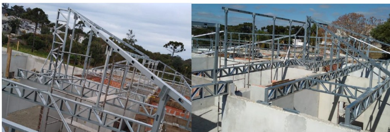
Figura 14 – Fixação das treliças de apoio
