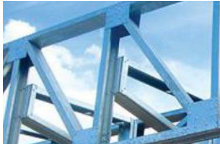
Figura 8 – Ligações de perfis com chapas Gusset
