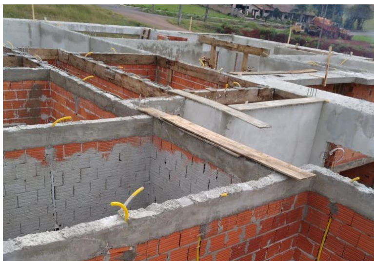
Figura 12 – Estrutura de concreto finalizada
