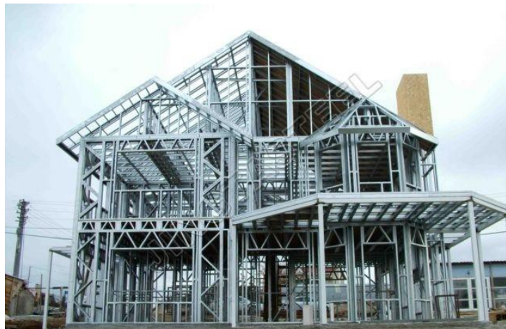
Figura 1 - Estrutura em LSF
