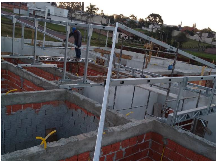
Figura 13 – Estrutura de concreto finalizada
