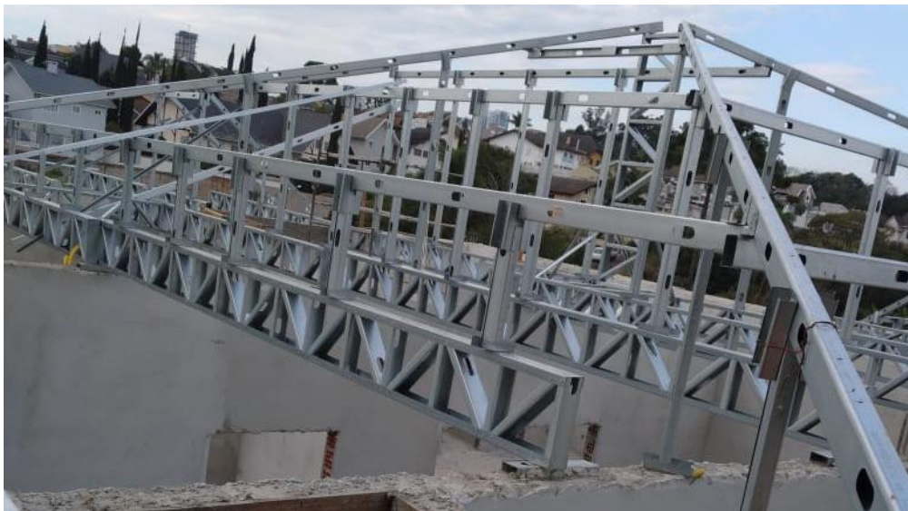
Figura 15 – Finalização da instalação das treliças
