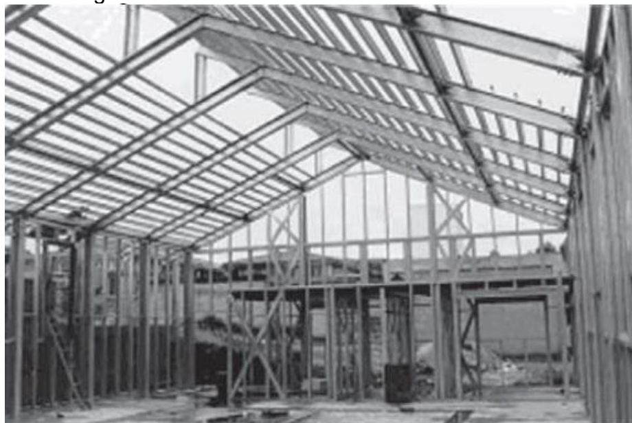
Figura 6 – Telhado estruturado com caibros
