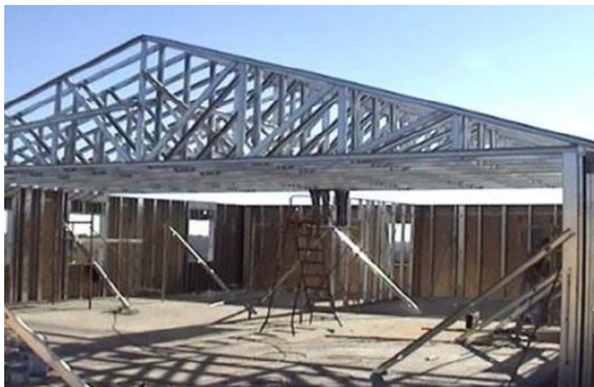
Figura 7 – Telhado em tesoura
