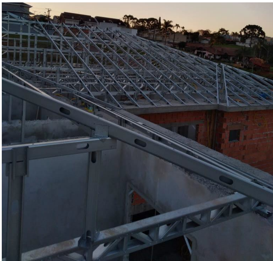
Figura 17 – Fixação dos caibros
