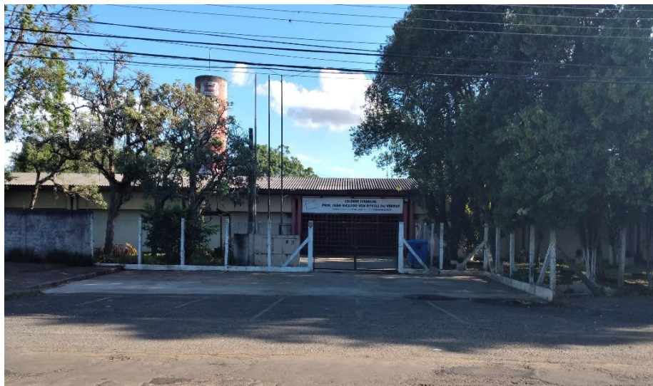
Imagem 7 – Fachada principal do Colégio Estadual Professor João Ricardo Von Borell du Vernay na cidade de Ponta Grossa / PR
