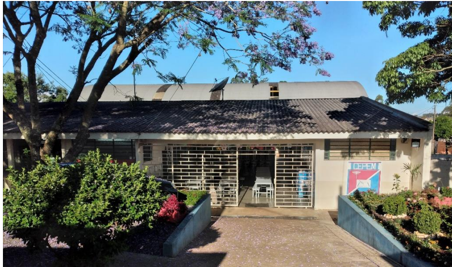
Imagem 16 – Fachada principal do Colégio Estadual Professor Eugênio Malanski na cidade de Ponta Grossa / PR
