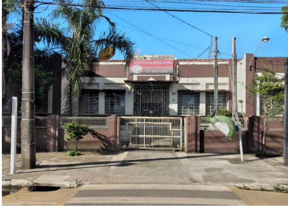
Imagem 4 – Fachada principal do Colégio Estadual General Osório na cidade de Ponta Grossa / PR
