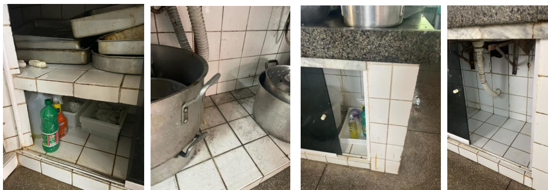
Figura 20 - Condições higiênico-sanitárias das instalações da UAN.
