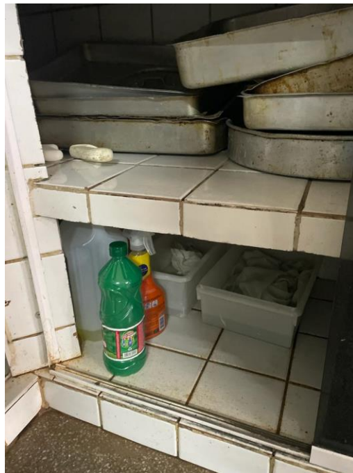
Figura 21 – Produtos de limpeza guardados em local não adequado.
