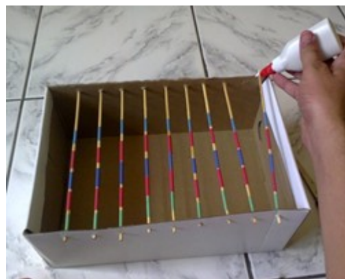
Figura 20 - Ilustração do passo 03 para construção do sorobã
