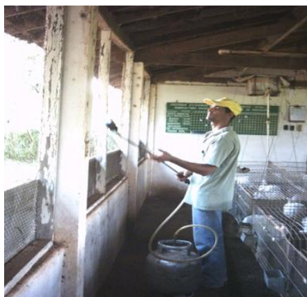
Figura 19 – A queima das instalações é uma norma crucial para prevenção de enfermidades
