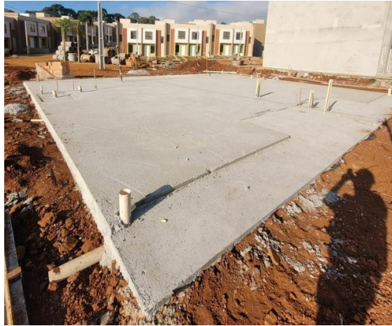
Figura 3 - Radier liso concretado e executado.
