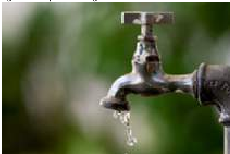
Figura 33 - Desperdício de água
