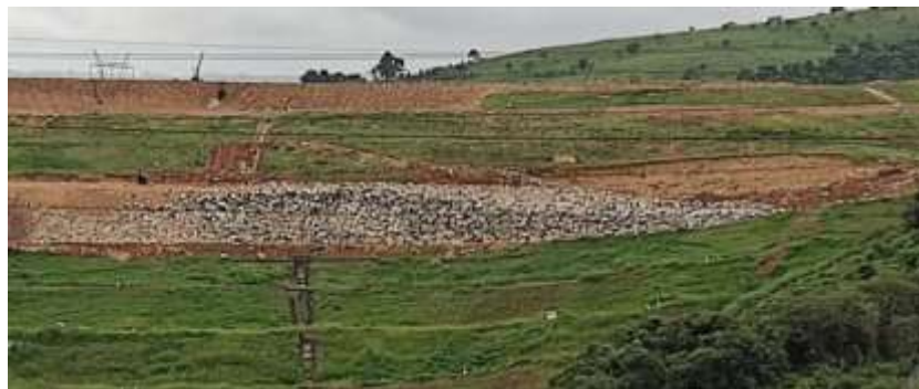
Figura 15: Aterro sanitário do bairro Refúgio dos Bandeirantes
