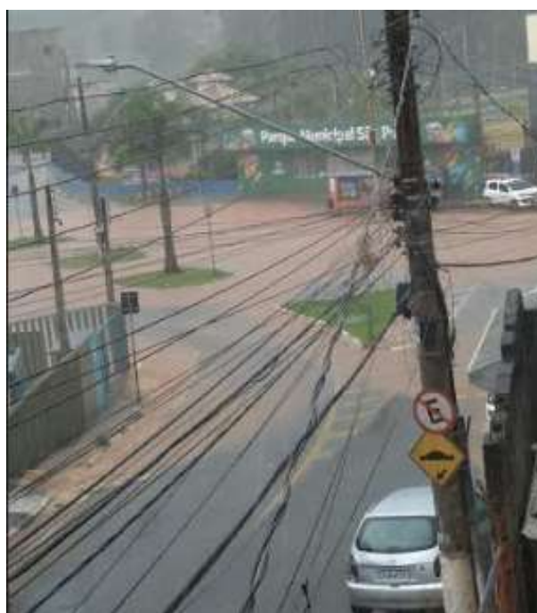
Figura 19: Ponto de alagamento
