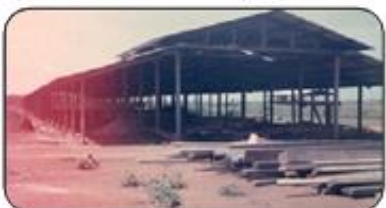
IMAGEM - 34 Construção do aviário
