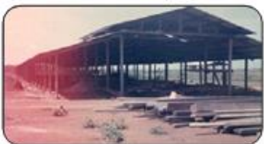
IMAGEM - 34 Construção do aviário
