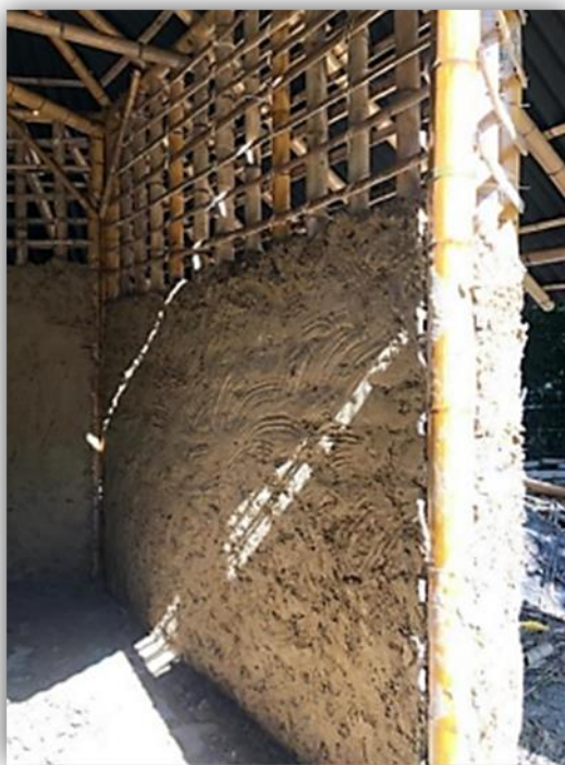
Figura 1: Parede de taipa de mão com bambu.
