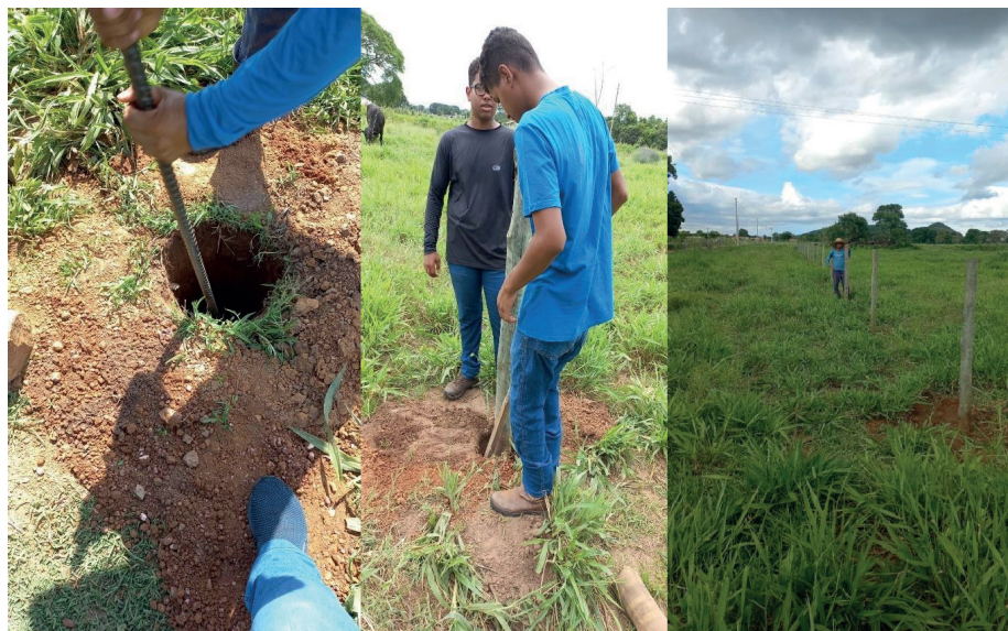
Figura 13: Serviço realizado para construção da nova área de pastejo do setor de ovinocultura
