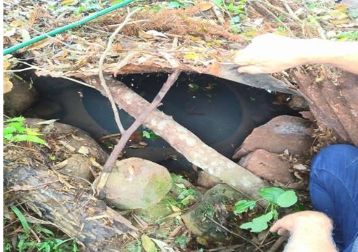
Figura 3- Nascente de água protegida de forma empírica na comunidade
