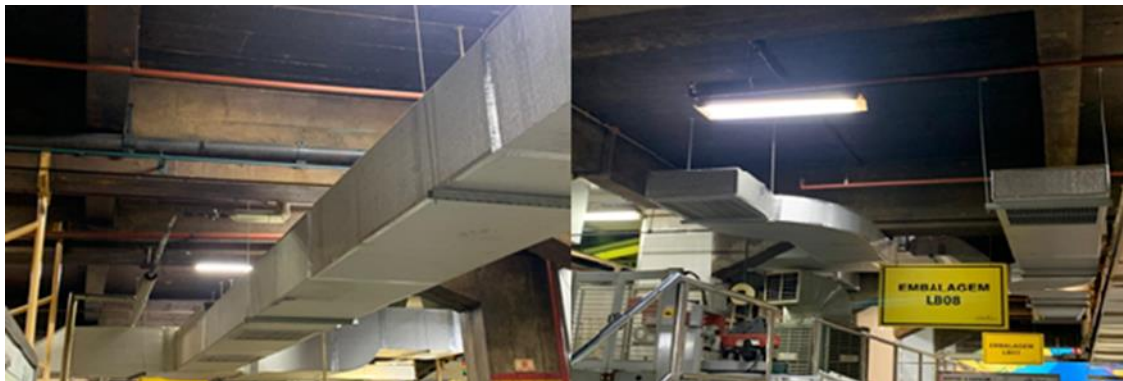
Figura 4 – Instalação de Fan Coil
