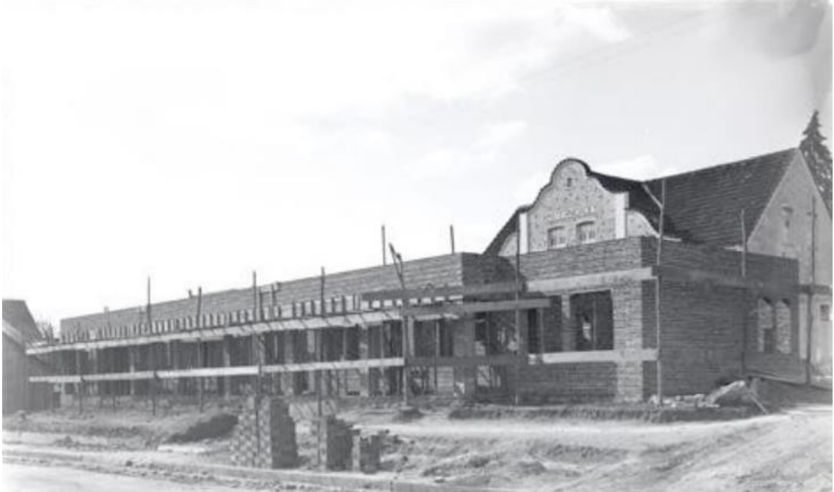
IMAGEM 14 - CONSTRUÇÃO DA MATERNIDADE EM FRENTE À ESCOLA ALEMÃ
