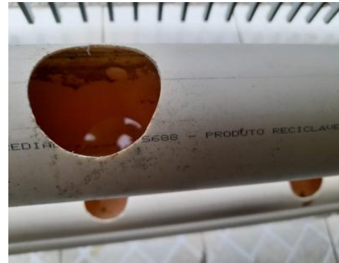
Não deixar orifícios abertos sem tampa. Fonte: Autor
