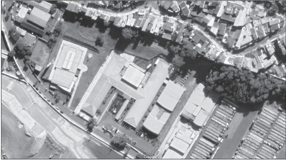
Figura 1 – Vista aérea da antiga Escola Municipal de Educação Profissional em Meio Ambiente
