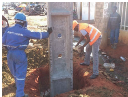
Figura 1. Implantação do poste em betão
