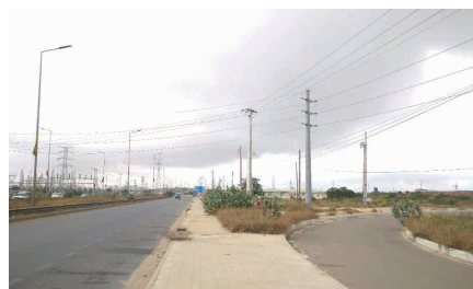
Figura 5. Estrada sendo atravessada por LT de MT com 12 m e LT de AT 22 m
