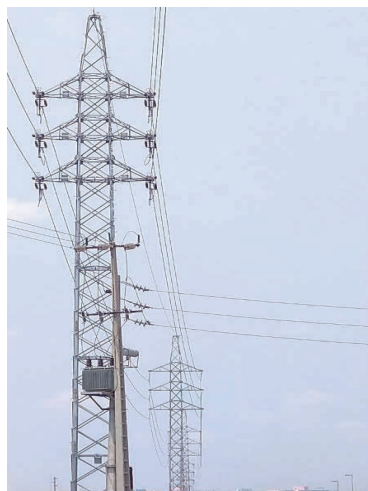
Figura 7. Cruzamento de LT 60 kV e 30 kV
