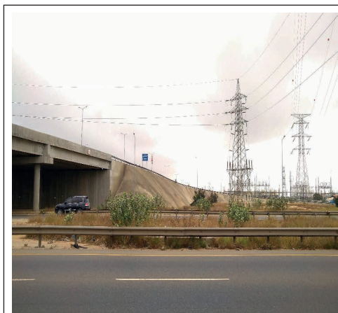
Figura 6. Cruzamento de LT 60 kV e 220 kV
