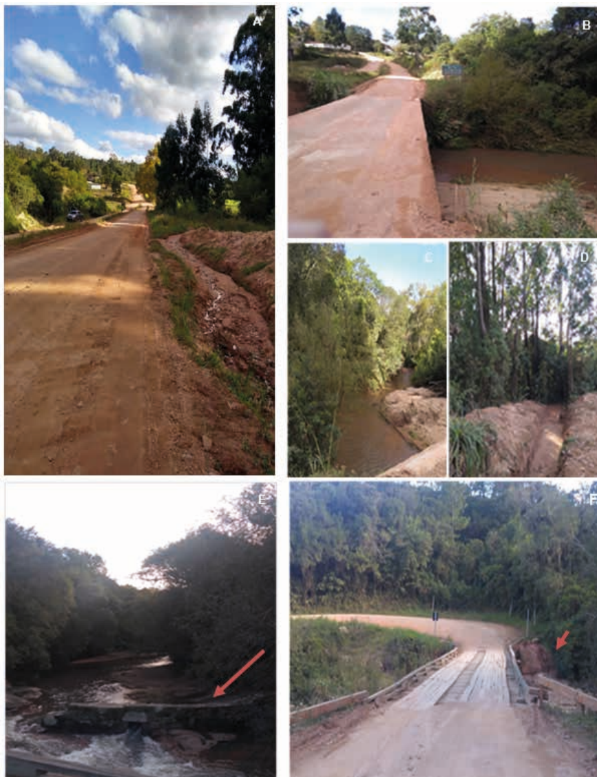
Figura 28: A) Efeito natural da drenagem pluvial em direção ao Arroio Pimenta (carregamento de sedimentos); B e C) Acúmulo de sedimentos no Arroio Pimenta; D) Canal de drenagem pluvial construído a jusante das áreas mais elevadas; E) Escoamento das águas pluviais para o Arroio Pimenta de áreas a montante (transporte de poluentes); F) Ponte sobre o Arroio Pimenta aparentando sem manutenção, mostrando-se uma estrutura frágil perante a ocorrência de fenômenos extremos como enxurradas. Presença de erosão linear na cabeceira da ponte. Espaço sem vegetação e com declividade (à direita).
