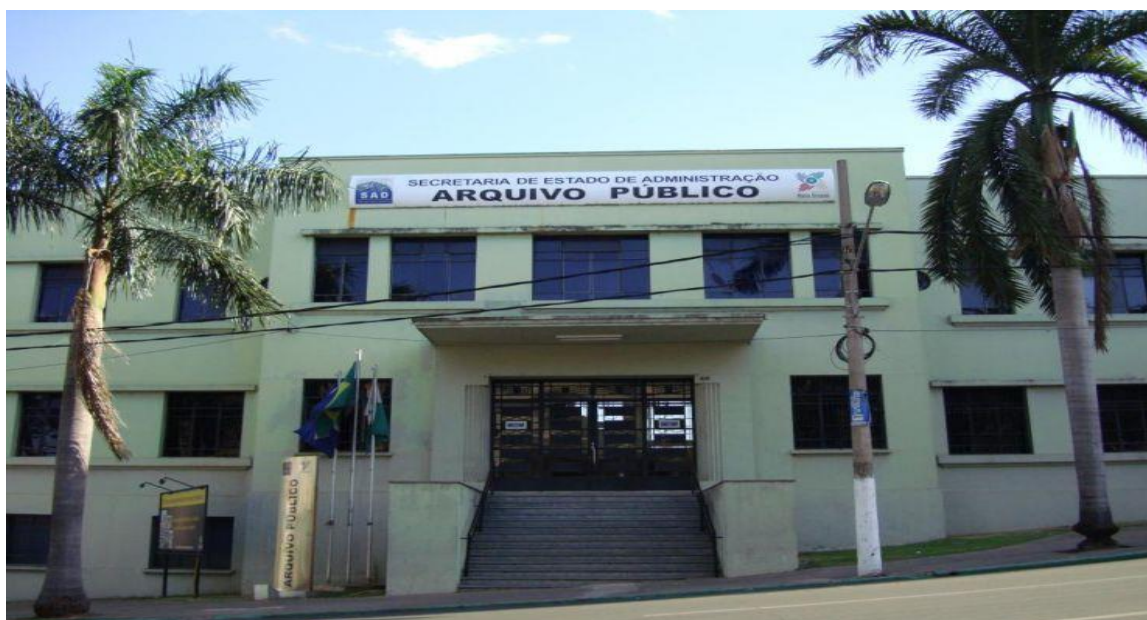
Figura 22 – Entrada principal do APMT
