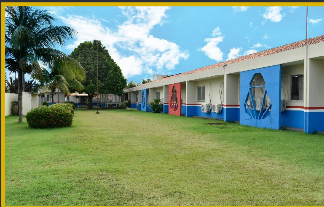
Imagem 1: Área de circulação externa da EETEPA/Tailândia Fonte: In foco studio fotográfico
