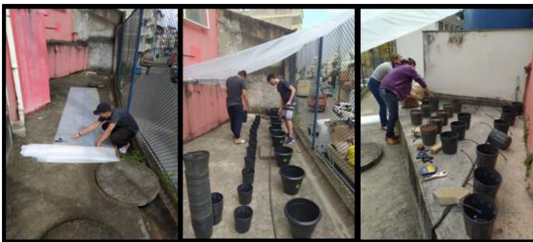
Figura 1 - Montagem da estrutura da estufa da horta escolar
