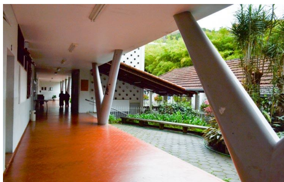
Parte interna da FFSD
