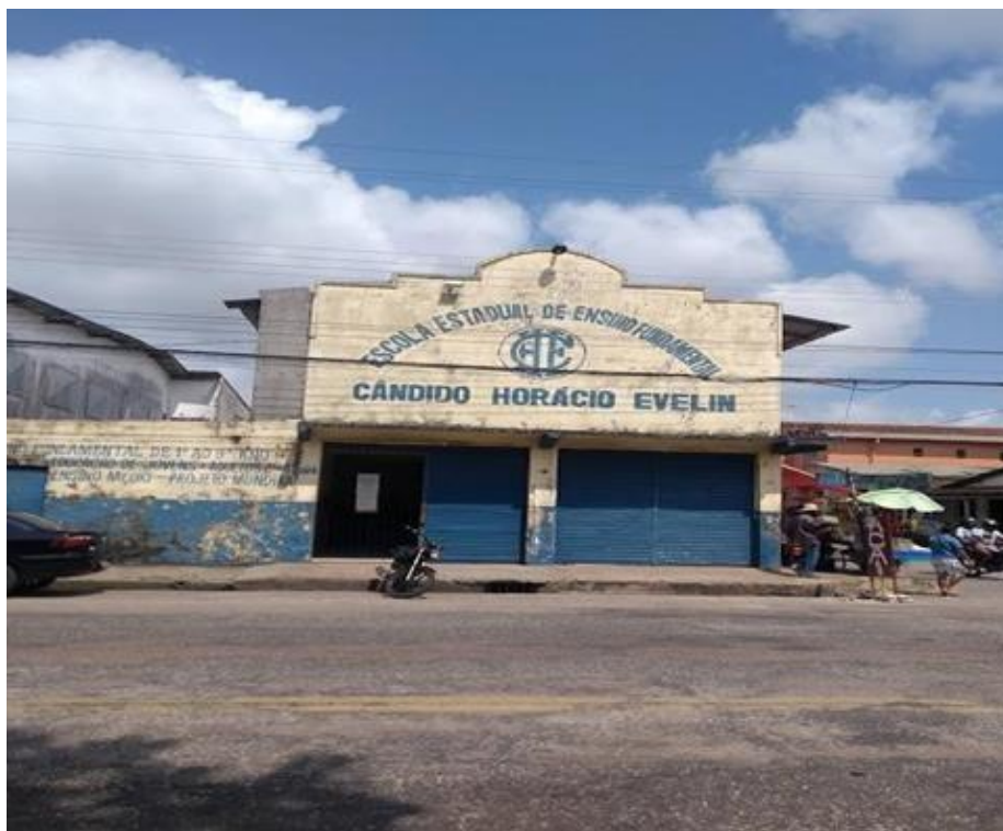
Figura 12 – Fachada da E. E. E. F. “Candido Horácio Evelin”
