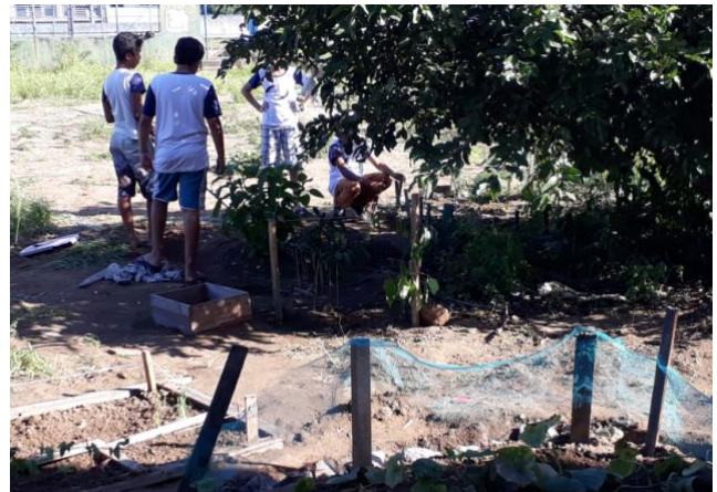
Fotografia 020 – Construção da horta/laboratório vivo na EEEF FAM no 1º Momento da problematização inicial (julho de 2017).
